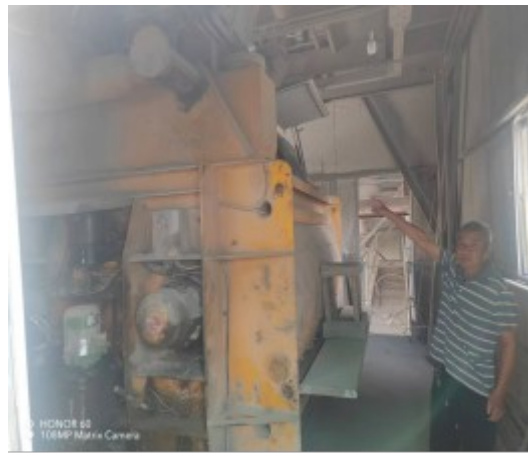
图2 事发搅拌机北侧检修门
