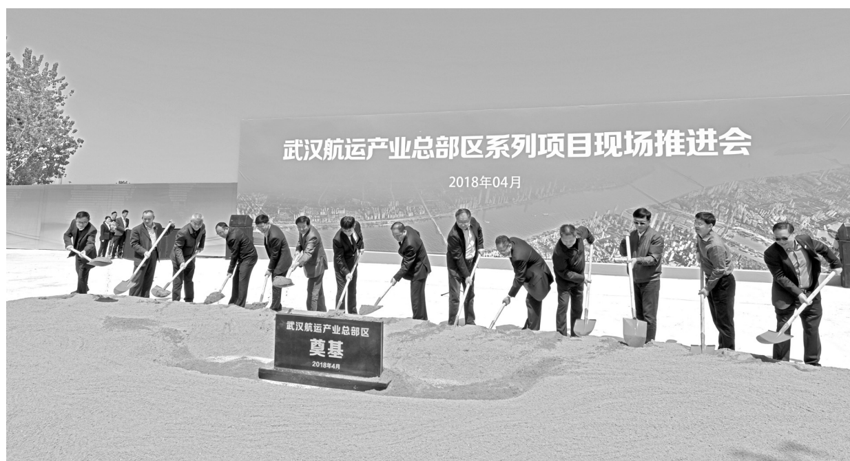
2018 年 4 月，武汉航运总部区奠基
