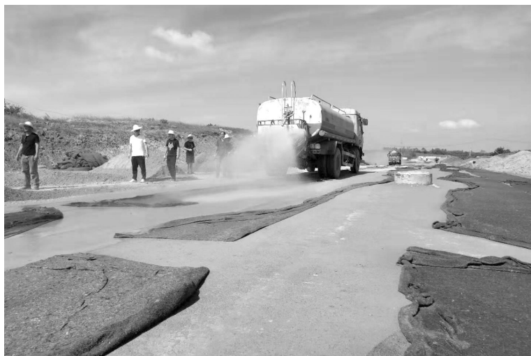
毕铺大道西段第一层水稳摊铺施工作业
