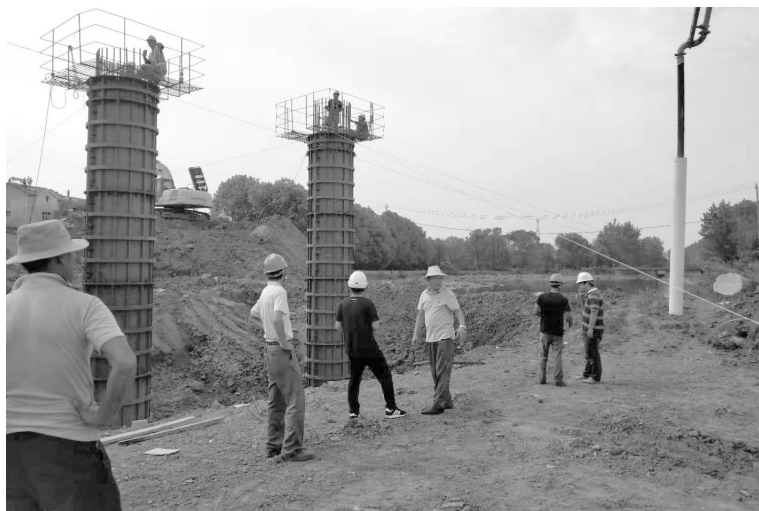
武英高速连接线项目,中桥墩段柱浇筑
