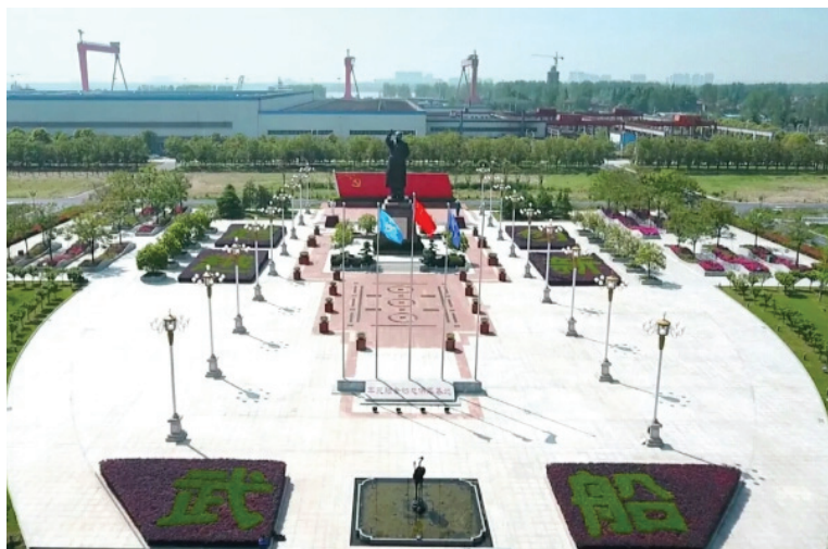
双柳武船重工基地厂景
