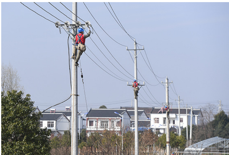
国网武汉市新洲区供电公司以乡村振兴、电力服务为己任，统筹安排，为淋江村进行网改（区供电公司 供图）
