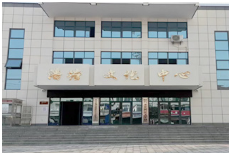
2022 年 10 月 25 日, 新洲区潘塘街新时代文明实践所 (公共文化服务中心) 维修项目竣工。
