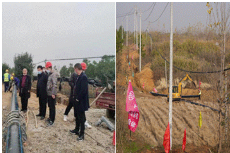
2022年10月15日，潘塘街人大代表提交的关于“进一步完善潘塘街道自来水管网升级改造”的议案得到落实，道观河水厂管网延伸工程项目正式开工（郭莹莹 供图）
