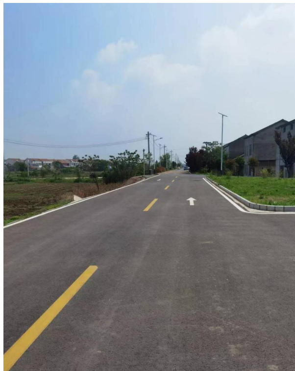
“五路八桥”郝城段全面完成 (郝城街 供图)
