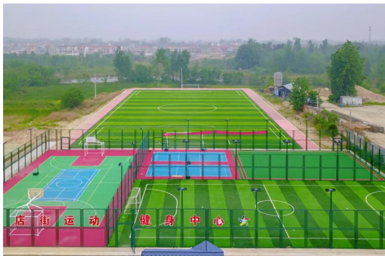
2022 年 5 月 16 日,新洲区三店街龙丘广场即将完成交付 (新洲融媒体 供图)
